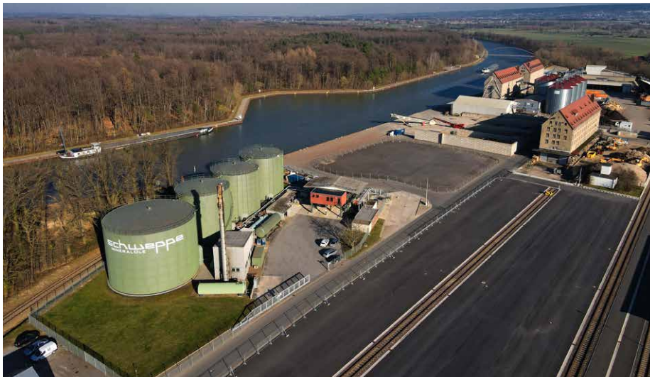
Der Hafen Bückeberg-Berenbusch ist per Bahn, Schiff und Lkw erreichbar.
